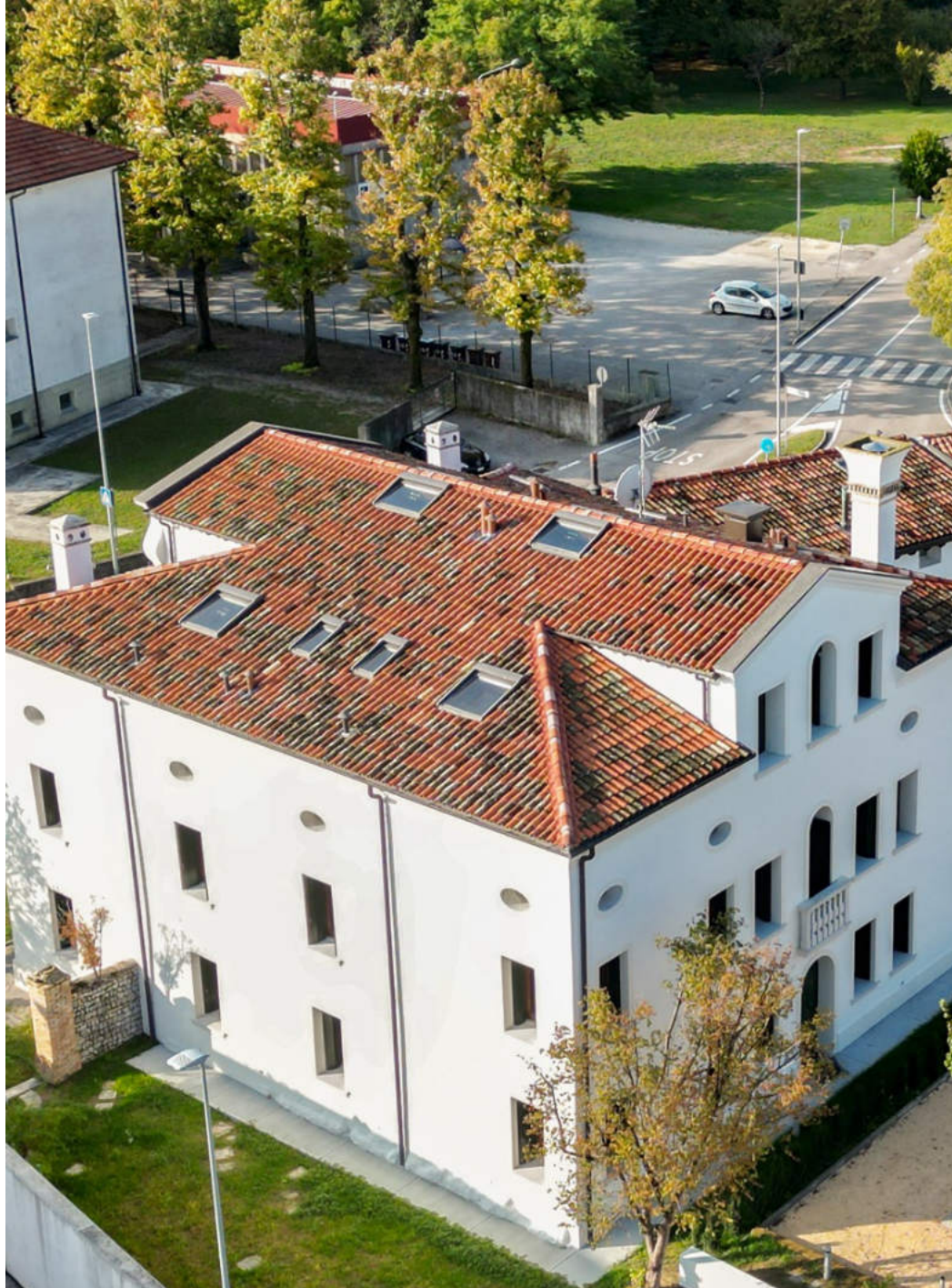
Ristrutturazione VILLA VIETTI | Porcia (PN)
