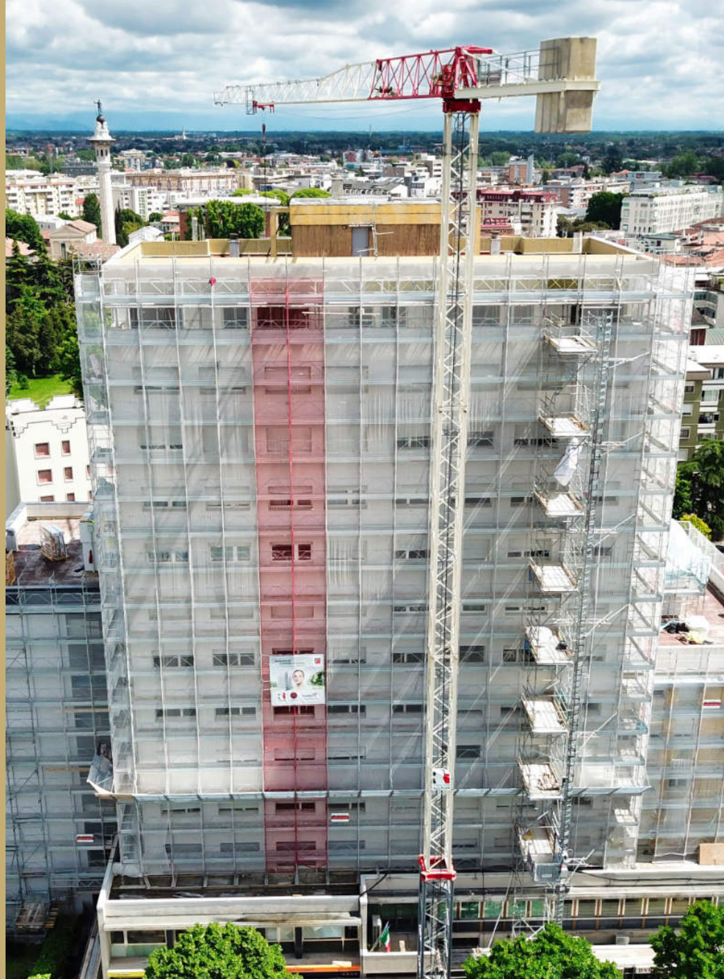
Ristrutturazione TORRE JULIA | Pordenone
