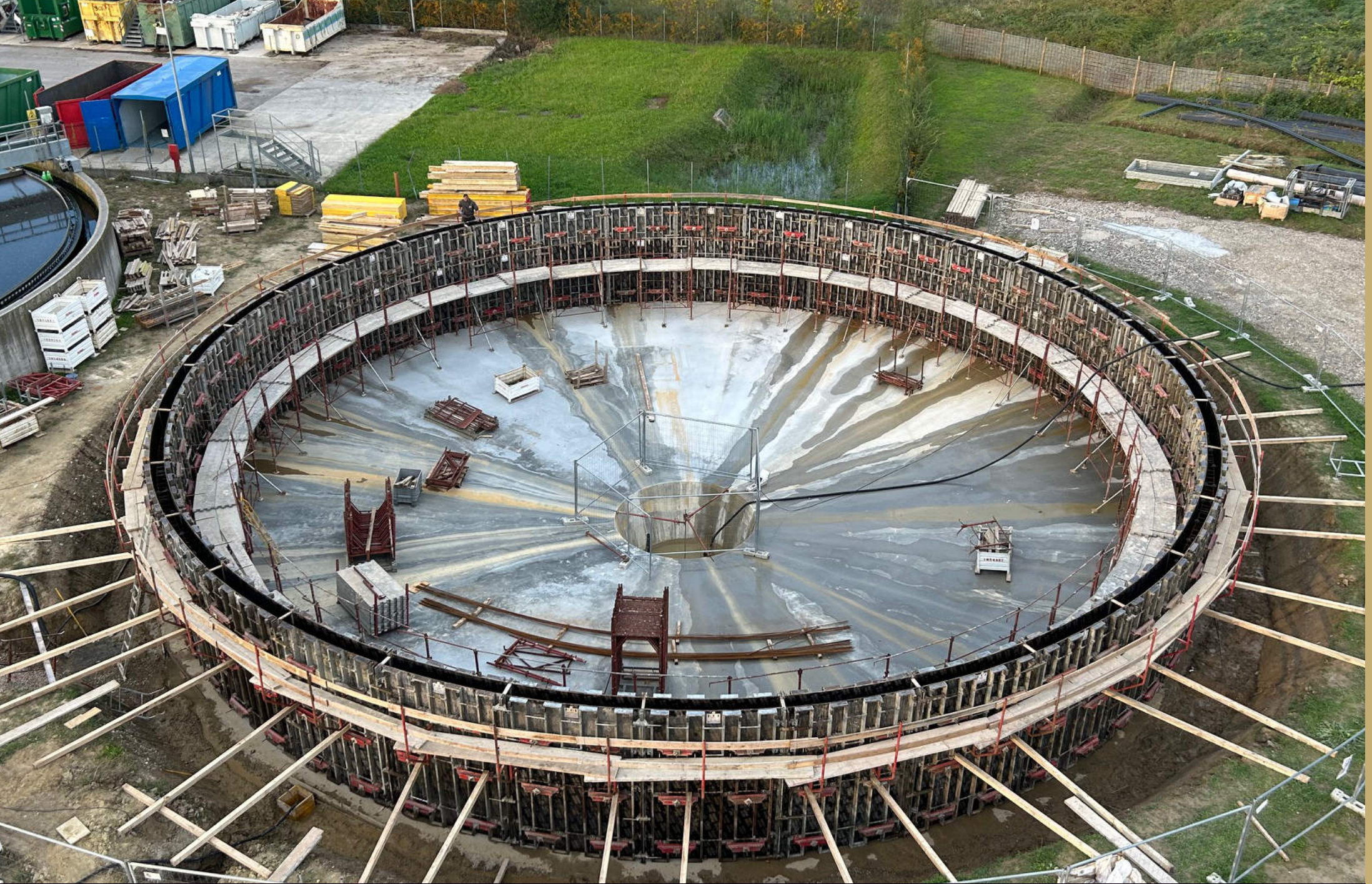
Nuovo impianto di depurazione PIAVE SERVIZI | Quarto d'Altino (VE)
