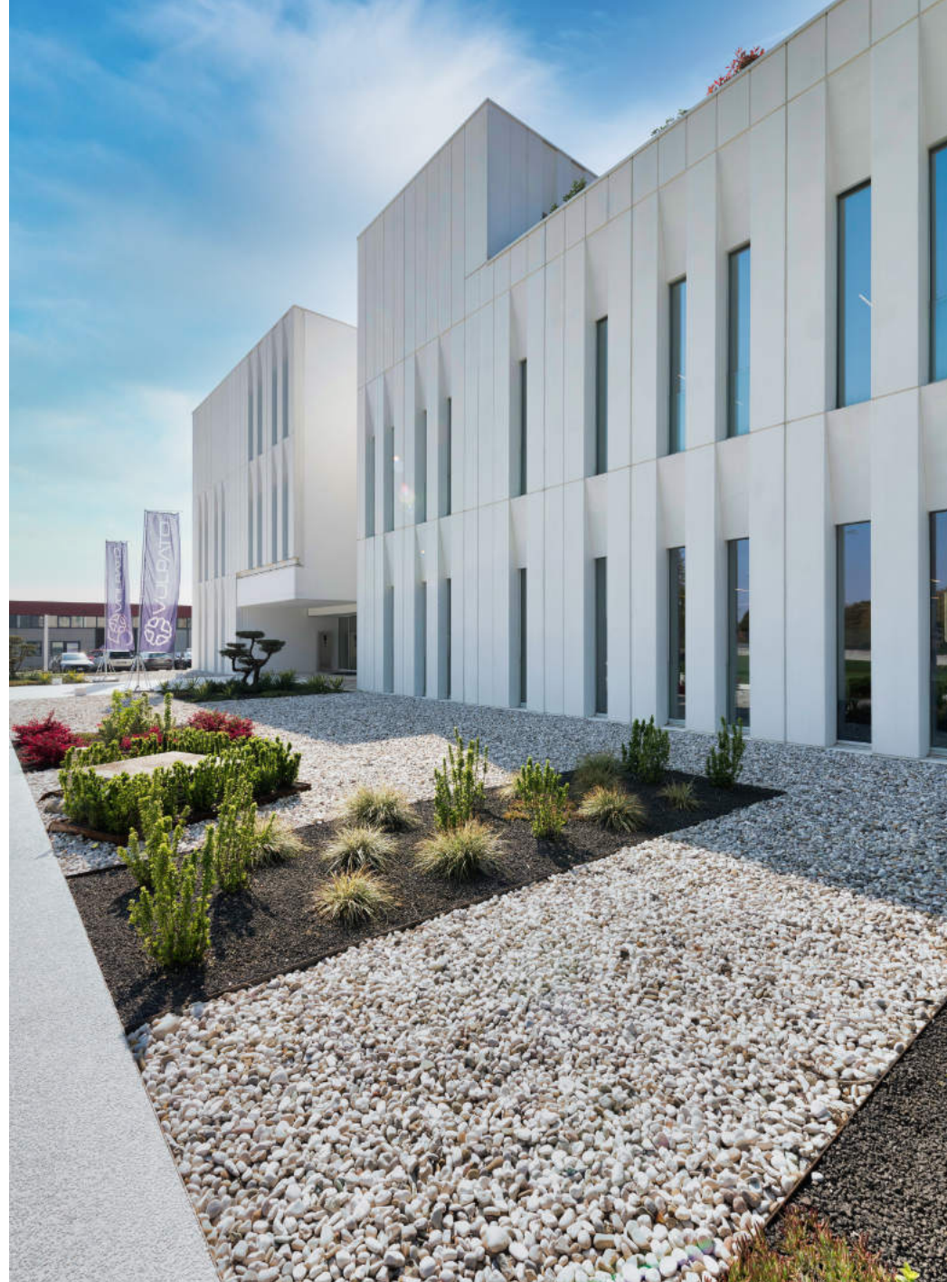
Realizzazione nuova palazzina uffici VOLPATO INDUSTRIE | Spresiano (TV)
