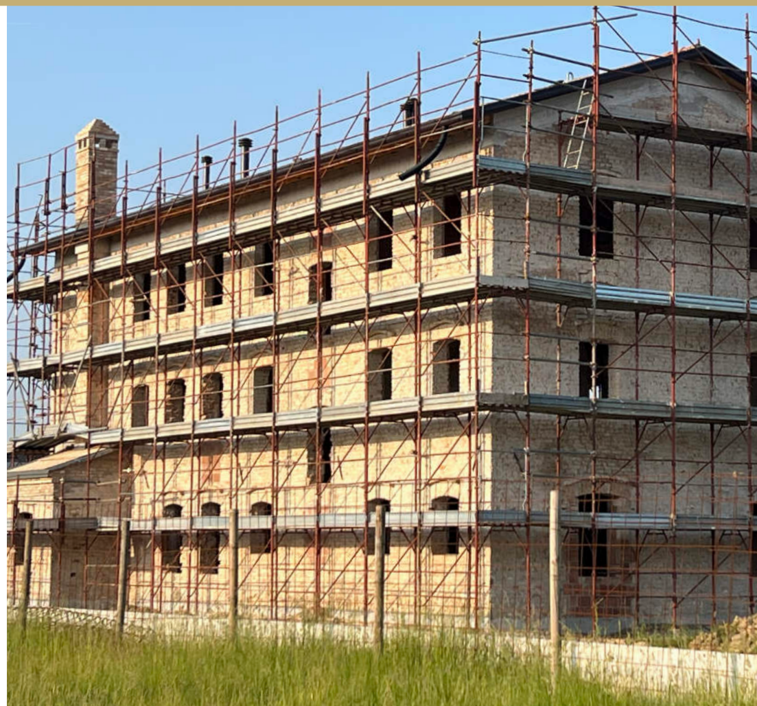
Ristrutturazione edificio residenziale | Meduna di Livenza (TV)
