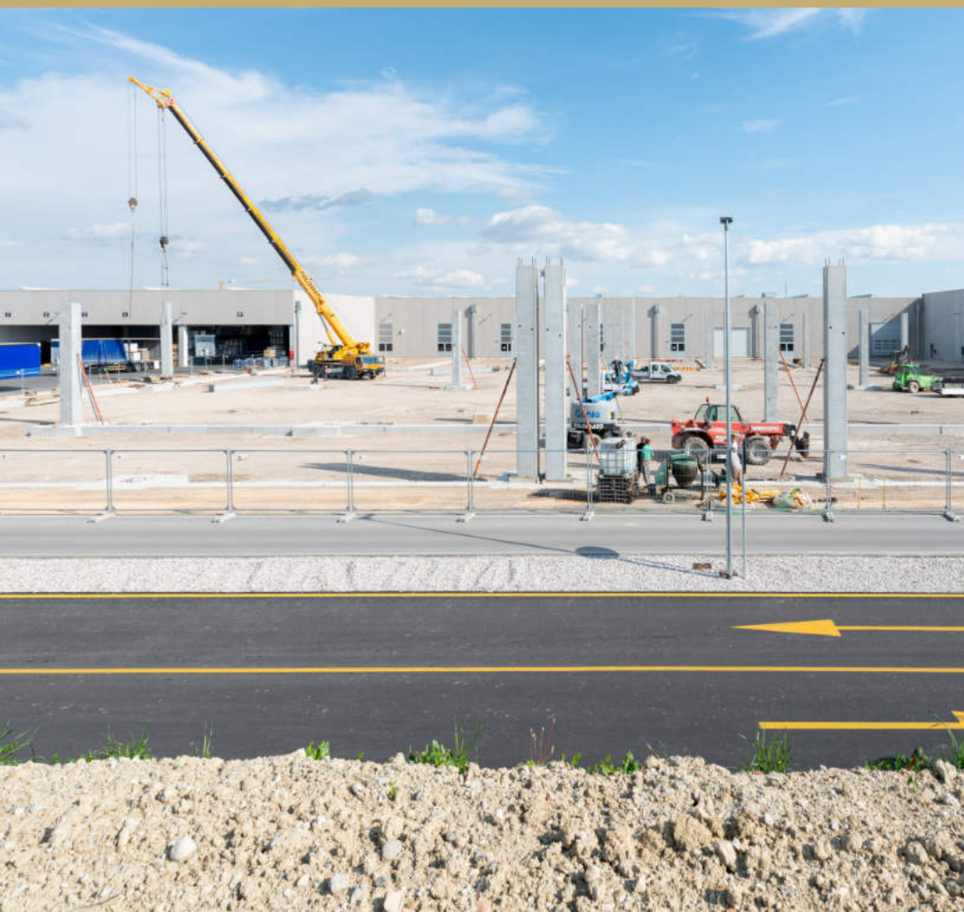
Ampliamento FRIUL INTAGLI Unit 1bis | Prata di Pordenone
